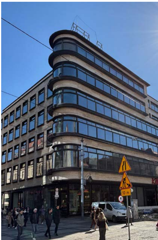
Das Kaufhaus Petersdorff in Wrocław, früher Breslau
